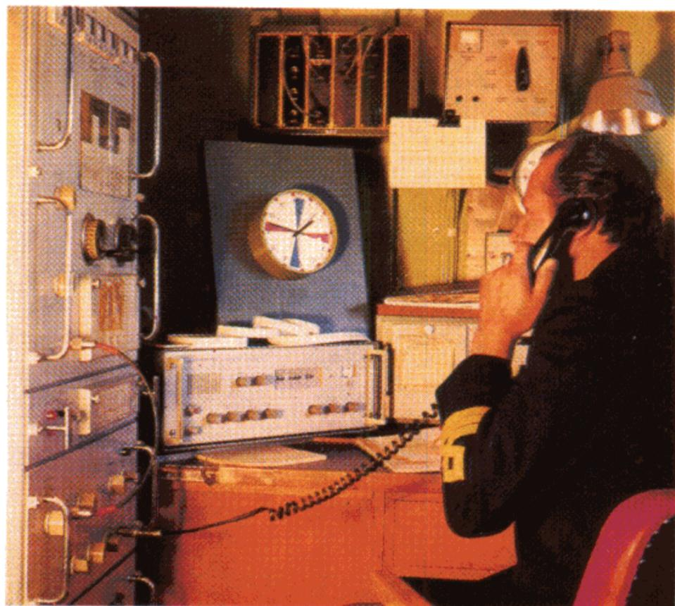
maximal 10 Sendern bis 20 kW Nennleistung auf maximal 19 Energieleitungen bzw. Antennen. In weniger als einer Sekunde ist ein Sender auf eine Antenne durchgeschaltet.
